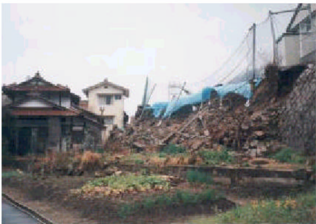
広島県河内町 河内小学校グランド周辺の石垣倒壊
