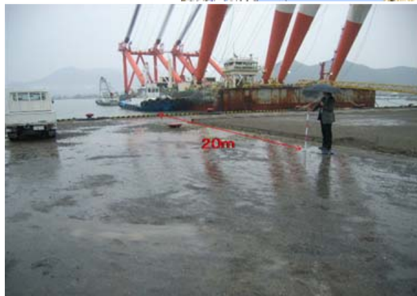
須崎港串の浦地区の浸水の痕跡
