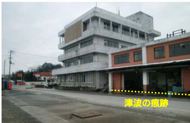
図 3 - 9 陸前高田市の現地調査の津波の痕跡
