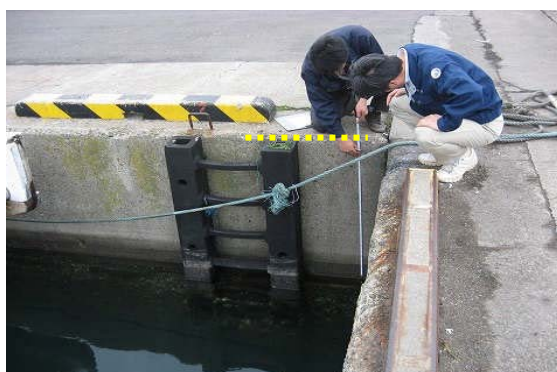
大洗港の岸壁上端から約 25cm 下に変色あり。
