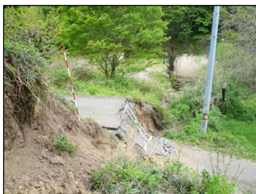
写真 2 道路を横切って露出した断層 (図 3-25②から撮影)
