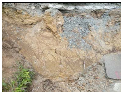
写真 3 写真 1 の断層崖の拡大 (図 3-25①から撮影)
