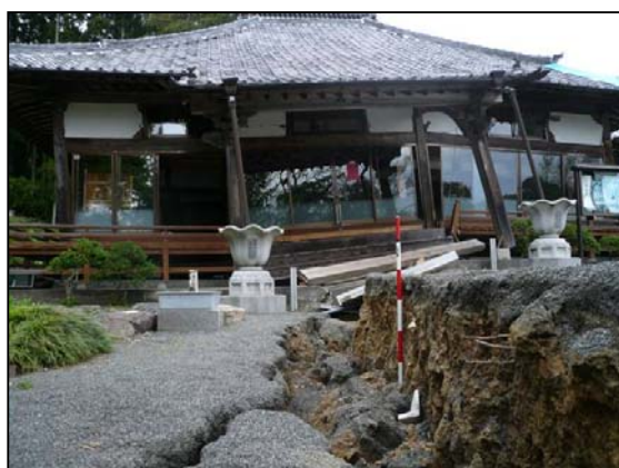
写真 6 被災した寺院（図 3-26⑤から撮影） 断層の走向は北西－南東方向。南西側がほぼ 垂直に沈下。沈下高は大きいところで約 0.8m
