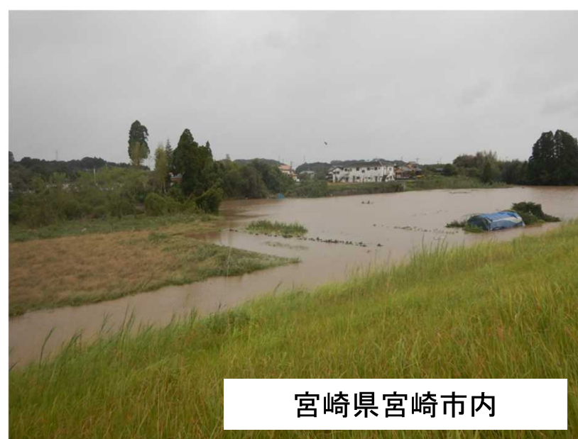
大淀川左岸15k400付近 堤内側を望む（9月19日10:00頃）
